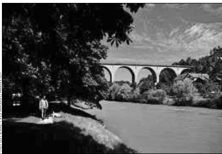
La Sarine aux abords de Fribourg. En bas à droite, Pierre-Alain Clément, syndic (PS): «Il ne faut pas oublier qu'à l'origine, la Sarine servait à transporter des marchandises. Tanneries, moulins ou encore brasseries se sont installés à proximité car ils avaient besoin de son eau.» FRIBOURG, 16 JUILLET 2014
