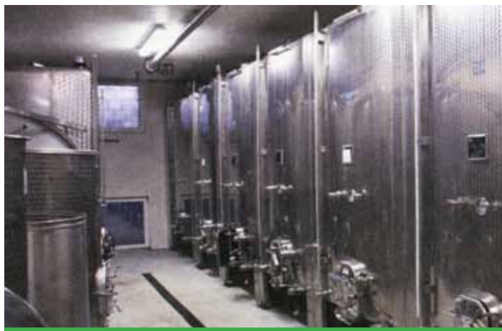
140'000 l de vin peuvent être stockés dans des cuves inox ultramodernes.
